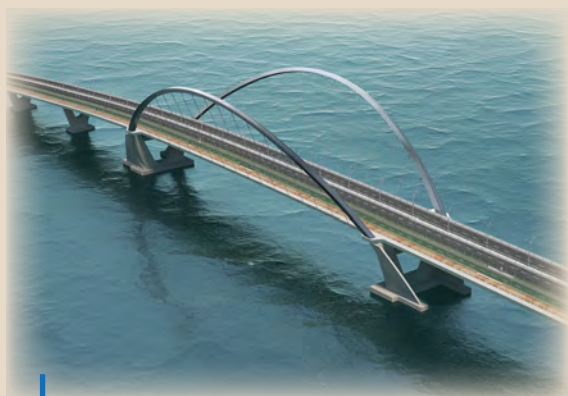
跨度200米長的鋼製拱橋 200-metre Span Steel Arch Bridge
