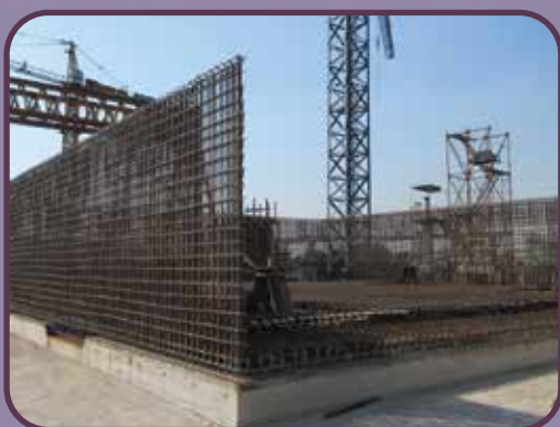
正在進行樁帽殼扎鐵工序 Fixing steel bars for pile-cap shell
