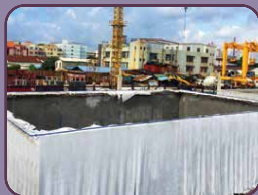
運用自動灑水系統進行混凝土養護工序 Using automatic sprinkler system for concrete curing works
